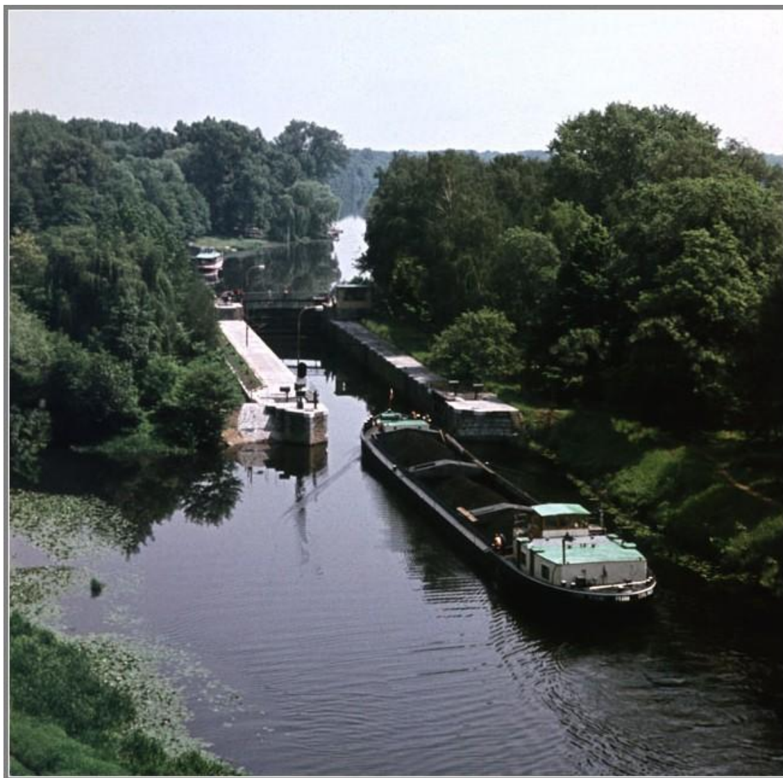
Pohled na původní plavební komoru z terasy zámku z laboratoří elektroniky (1958).
