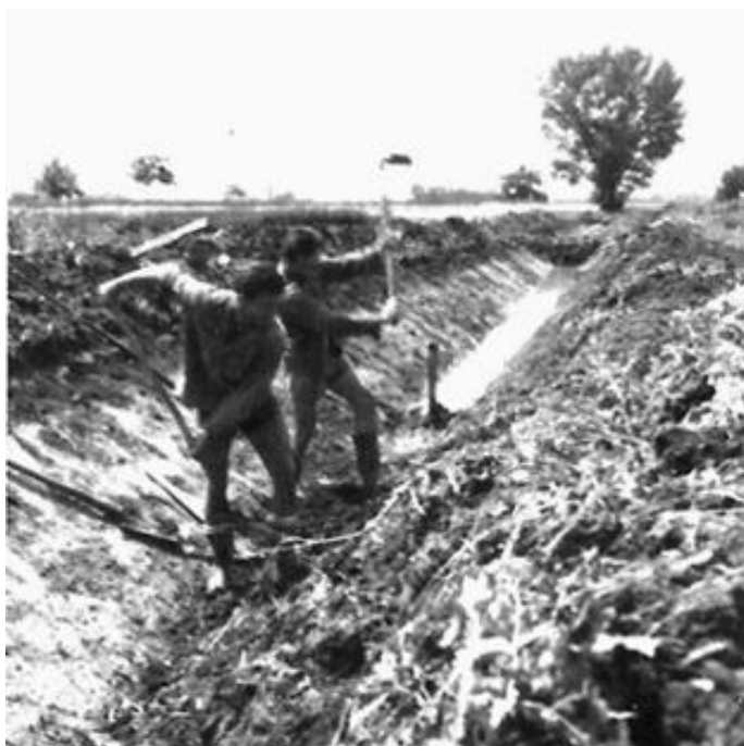
Obr. 12 Na melioračných prácach – svahovanie kanálov (V.Ružička, L.Kult)
