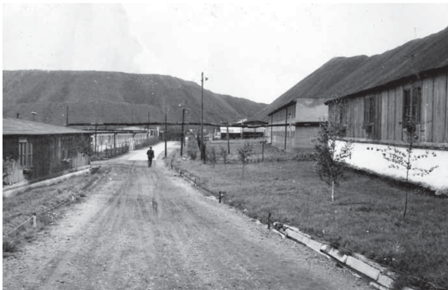
Pohled na hlavní bránu věznice v r. 1968, vpravo uprostřed budova kázeňských trestů (SOkA Pífbrem)
