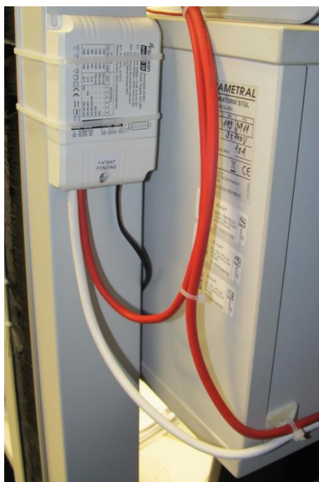
Obr. 3-7 – Umístění DALI předřadníky proLED25
