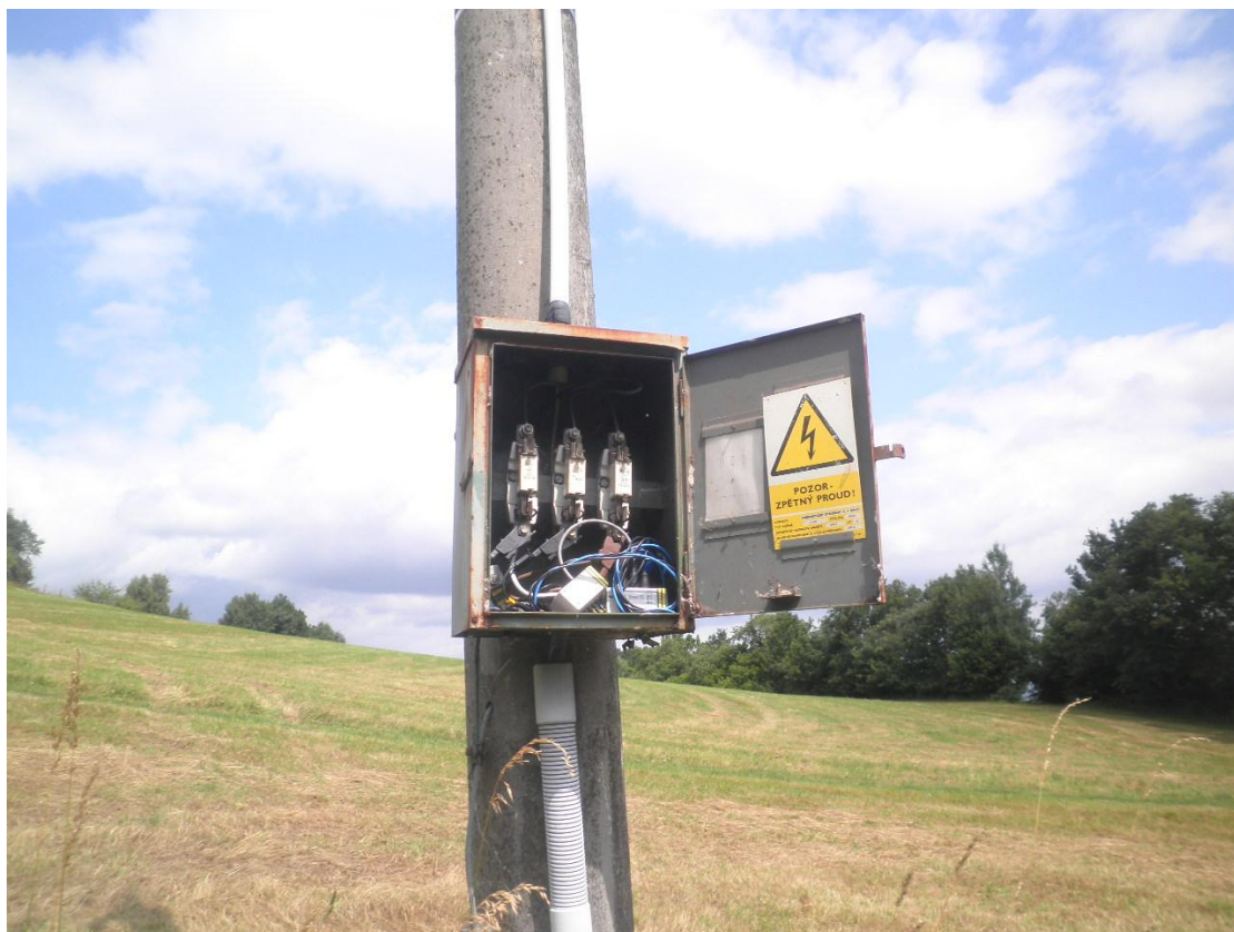
Obrázek 9 - Osazení skříně SV 101 (OM1 - síť Vitějovice) pomocí přístroje SIMON PQ
