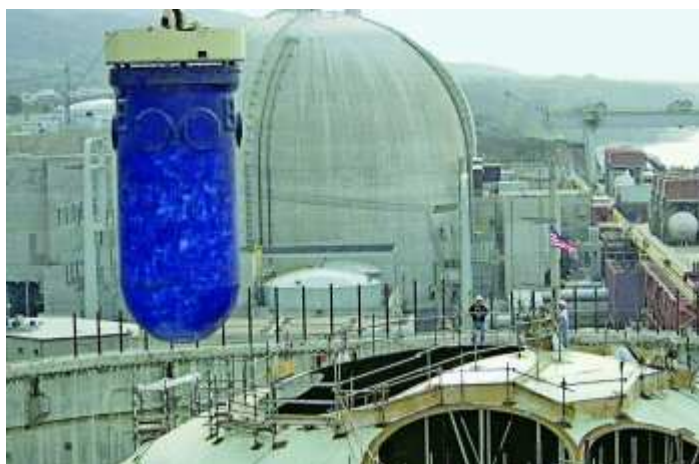
Obr. 4: Vyjmutí reaktoru z JE San Onofre skrz otvor ve střeše kontejnmentu ( http://cen.acs.org/ )
