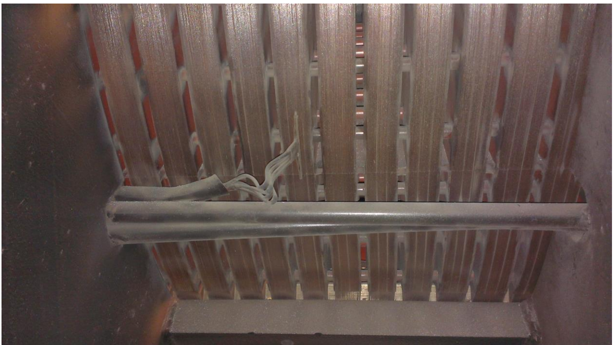
Obr. 4.1.2 – Detail statorových plechů (zde s měřením teploty)
